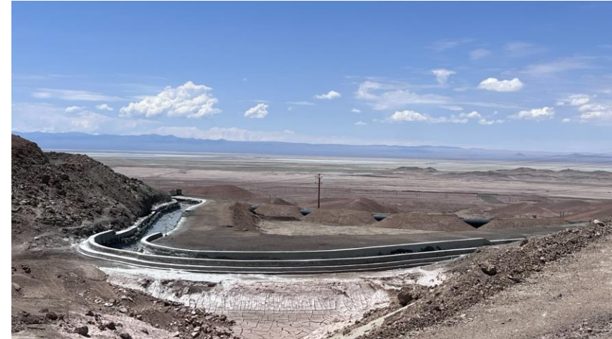
Canaleta Relaves, 2023. Foto: FF
