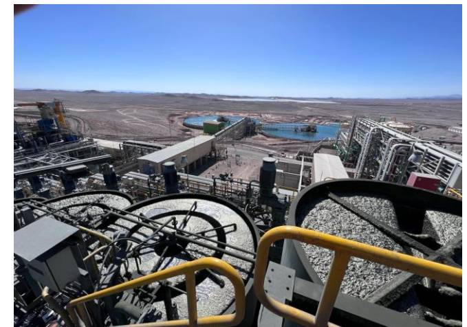
Celdas SFR, BHP Spence, 2023. Foto: FF
